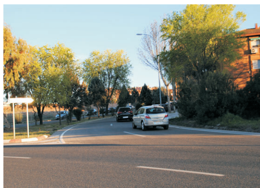
En esta entrada al barrio falta señalización.
