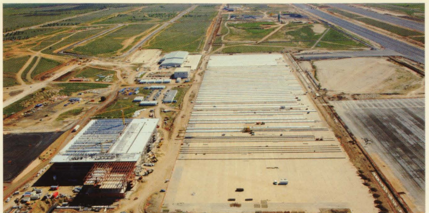
Vista aérea parcial de las instalaciones del aeropuerto.
