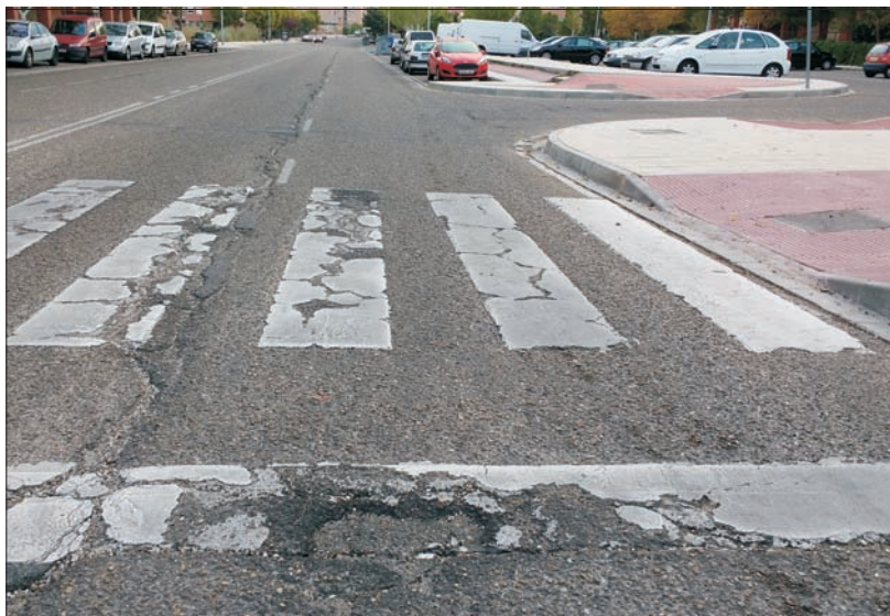
Guadarrama, Boladiez y Fresnedoso, en la imagen, serán asfaltadas en nuestro barrio.
