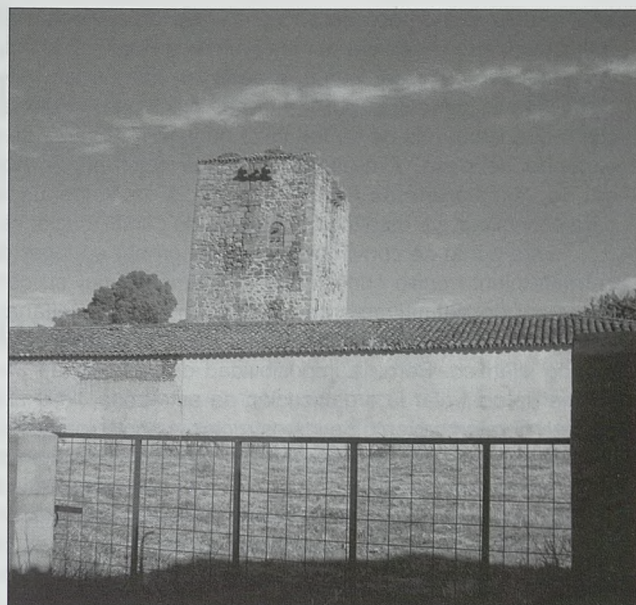
Fig. 5. Vista de la torre del Homenaje del castillo de Almaraz dentro de la finca agropecuaria que la custodia actualmente
