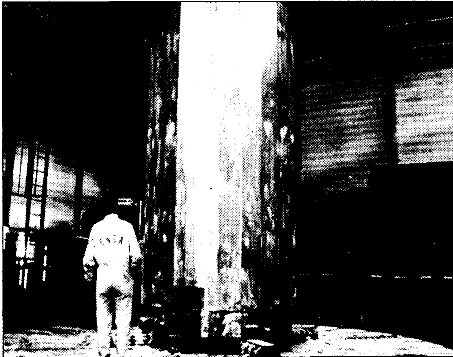
Los dos contenedores de la central están prácticamente terminados.
