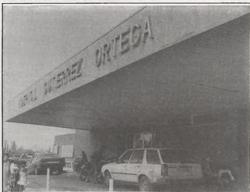
Fachada del Hospital
