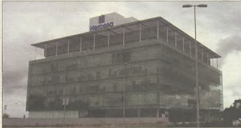
Jazztel se instalará en el edificio de Hercesa, próximo al C.C. Ferial Plaza
