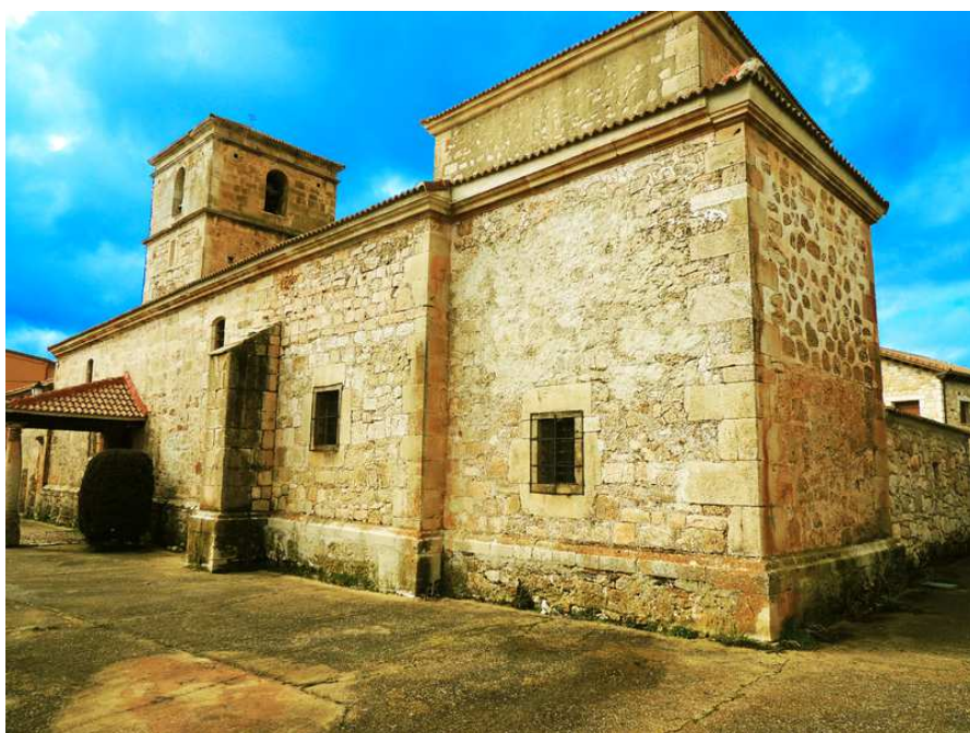
En 1866 concluyeron las cobras de reconstrucción de la iglesia de Cantalojas
