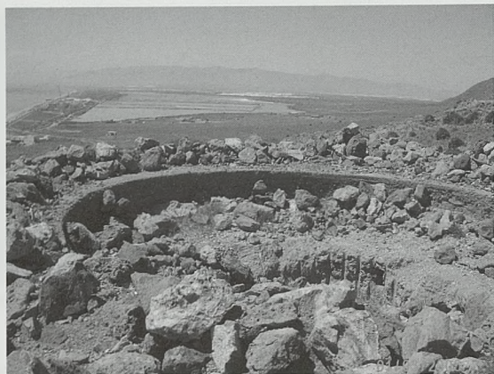
Batería I, Norte. Restos del emplazamiento del cañón Vickers 152 mm, en Cabo de Gata. Se observan los restos de tornillería del anclaje del cañón al suelo
