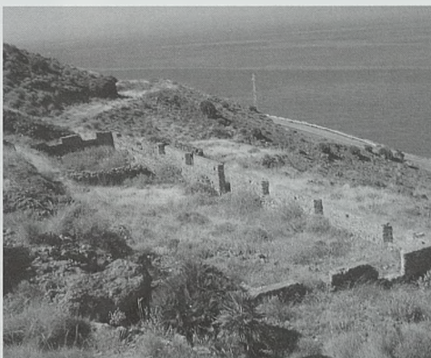
Barracón situado entre las dos baterías de Cabo de Gata
