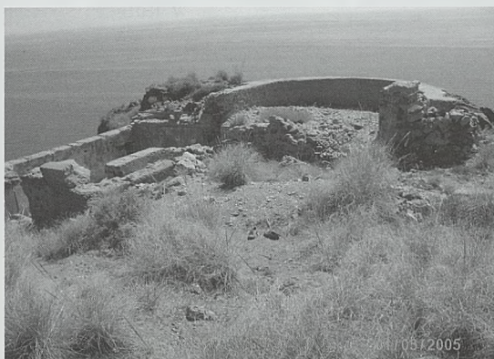
Observatorio de vigilancia y puesto de mando y telemetría de las baterías de Cabo de Gata
