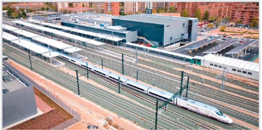
Llegada del Ave a la estación de Albacete Los LLanos.
