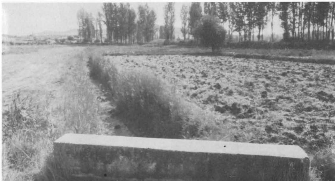
El cauce del Jabalón aparece totalmente seco
