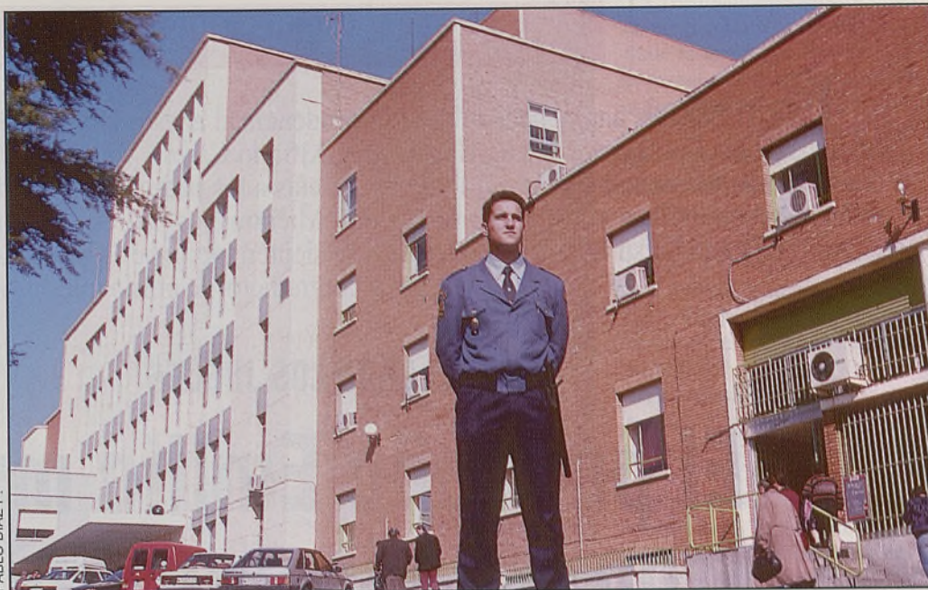
El hospital Alarcos de Ciudad Real.
