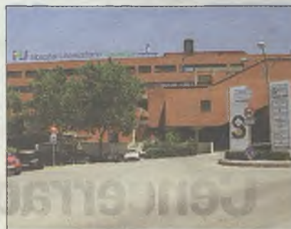
Fachada del Hospital de Guadalajara
