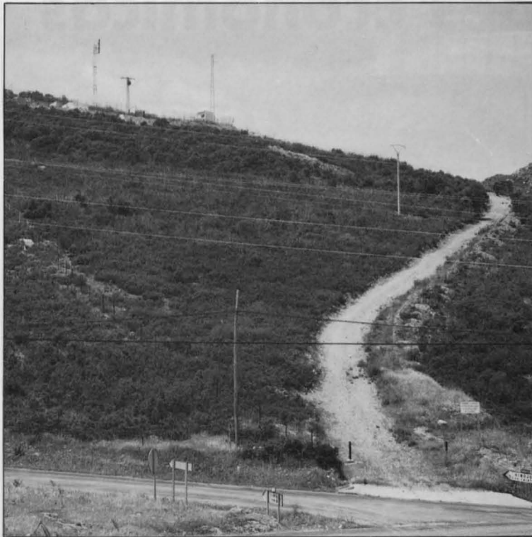
Vista del repetidor de TV del Puerto de Mestanza que retransmite la señal de Canal Sur
