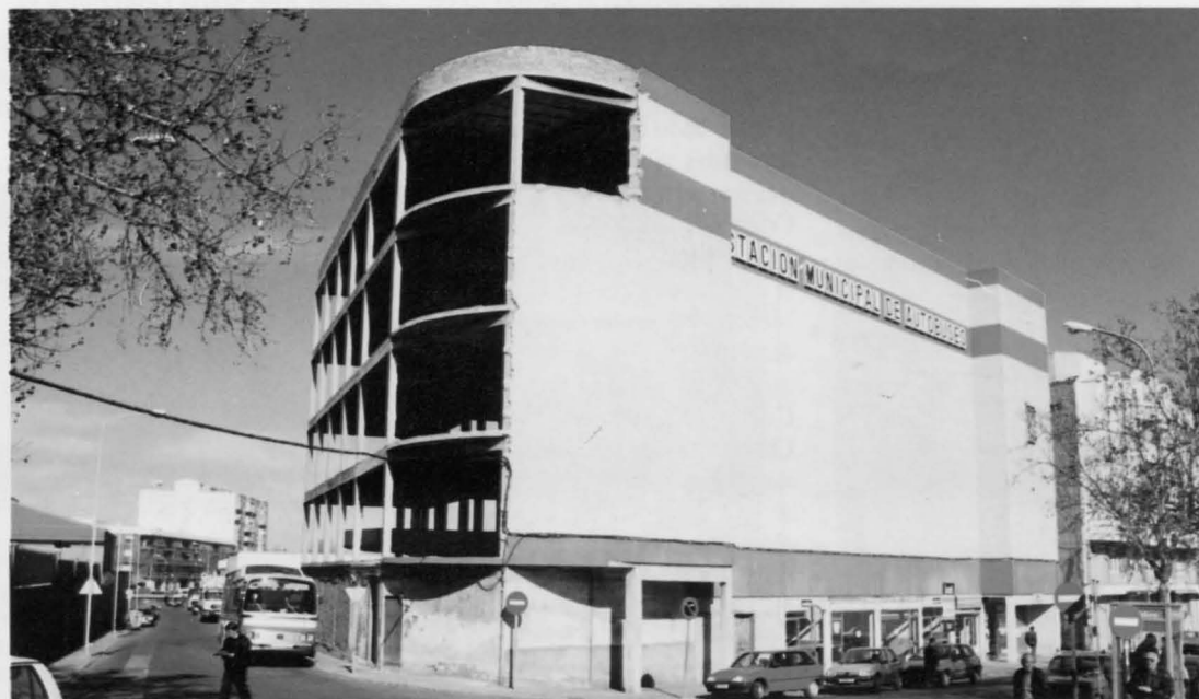
En el edificio que alberga la estación municipal de autobuses se instalará también la Policía Local
