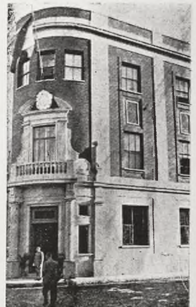
Edificio de Teléfonos
