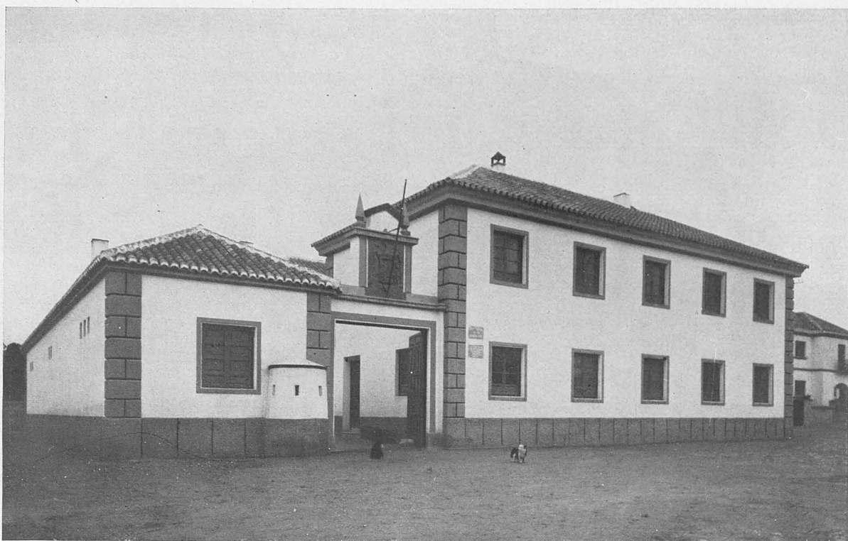
JAYENA.—Casa Cuartel para la Guardia Civil. Fachada principal. Al fondo, el nuevo grupo escolar.
