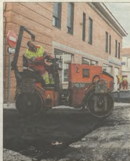
Una de las últimas obras ejecutadas.
