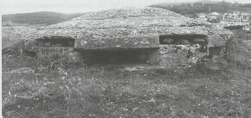
Fig. 14. Nido de ametralladoras de Primosto (Bárcena de Cicero)
