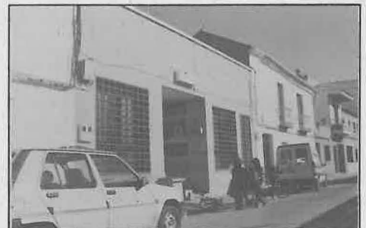
La Construcción del Centro de Salud ha permitido una mayor dotación de medios técnicos y humanos en el campo sanitario.
