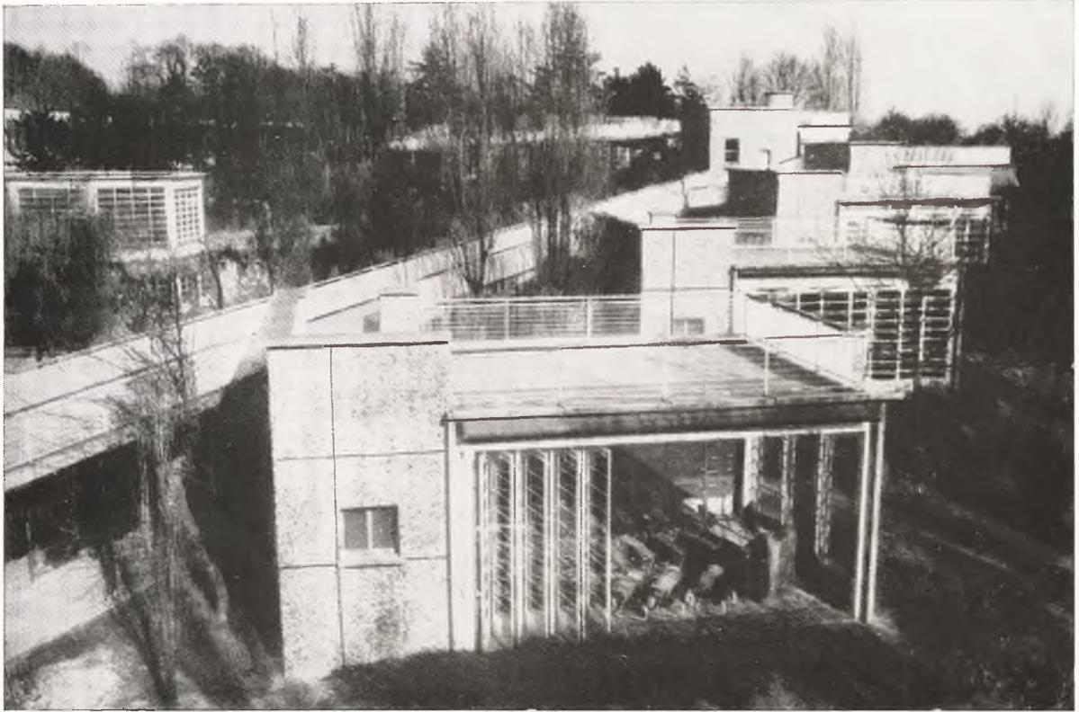
*SURESNES.—Escuela al aire libre. Carpintería metálica. Revestimiento exterior con losetas de hormigón prefabricado. Arquitectos, Beaudouin y Lods.—Abajo: BOULOGNE SUR MER.—Bloque de viviendas construidas en hormigón armado, vibrado y prefabricado. Arquitecto, M. Sonrez.*
