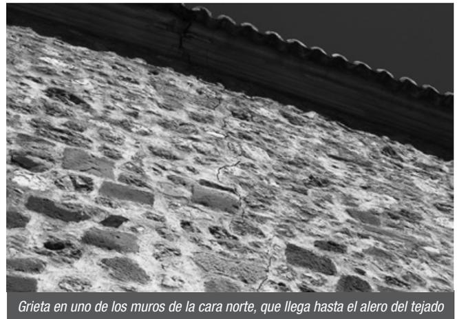
*Grieta en uno de los muros de la cara norte, que llega hasta el alero del tejado*
