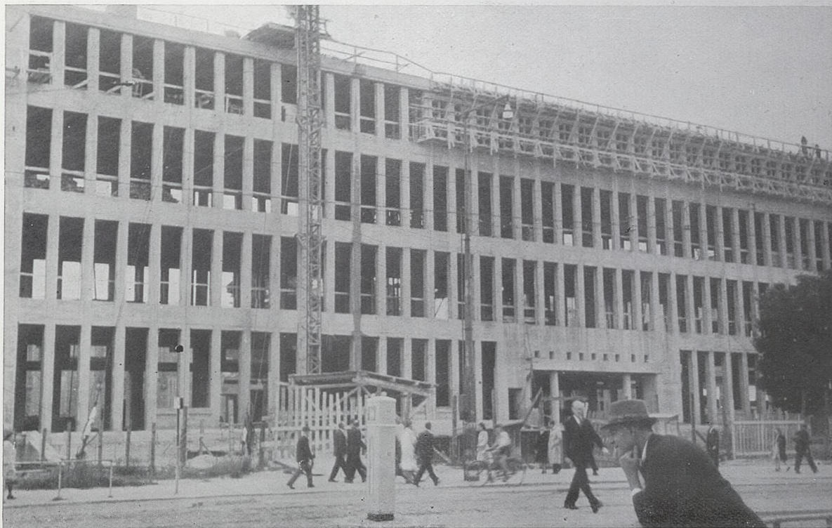
Edificio bancario, en construcción, en el nuevo centro comercial de Rotterdam.
