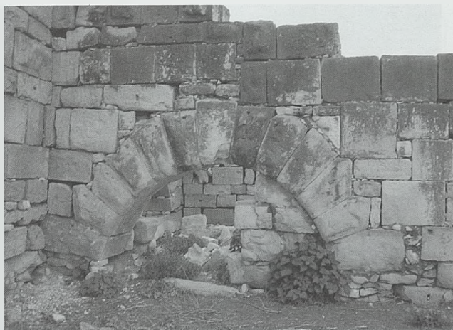
Ain Tounga: puerta de entrada a la fortaleza, semienterrada
