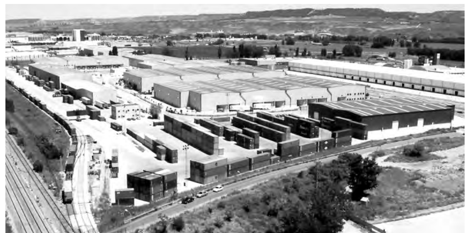
Imagen aérea de las instalaciones del Puerto Seco en la localidad de Azuqueca de Henares. /E. de G.
