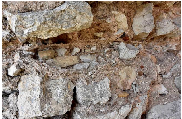
Calizas unidas por mortero
