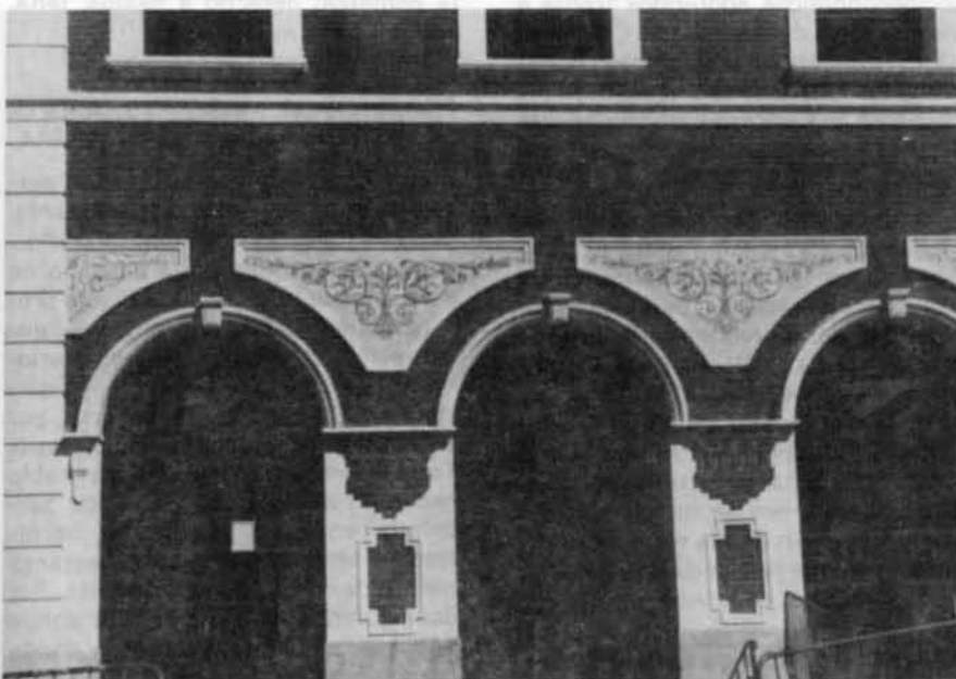
Detalle de la fachada.
