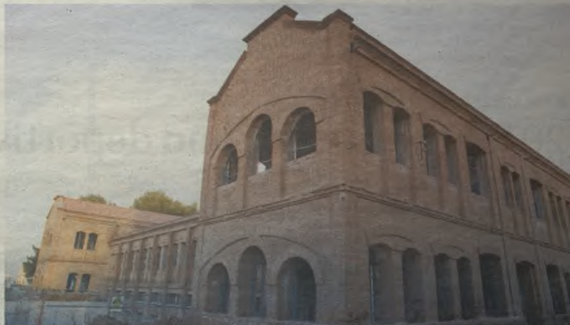
El Cuartel del Henares, otro ejemplo de recuperación de un edificio antiguo.
