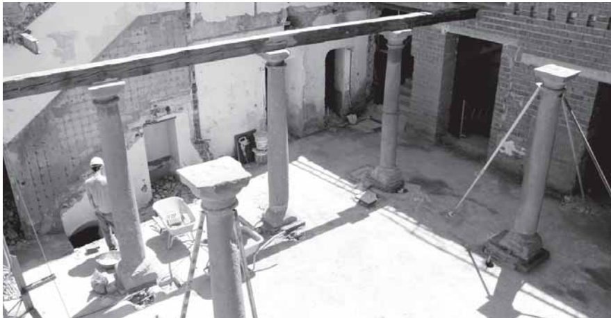
Aspecto de las obras en la Casa de la Hojarasca.
