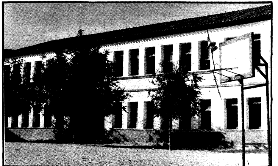
El magnífico Grupo Escolar de ocho aulas con un gran patio de recreo.
