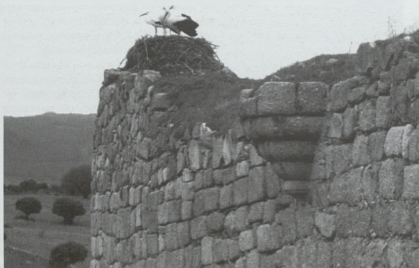
Restos de una garita en acordeón en el muro del siglo XV que cerraba el castillo por el Oeste
