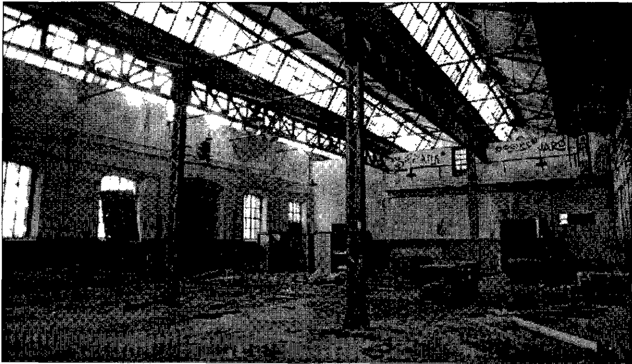
ABADONO Aspecto interior del cuartel de Daoíz y Velarde, fotografiado en marzo de este año.
