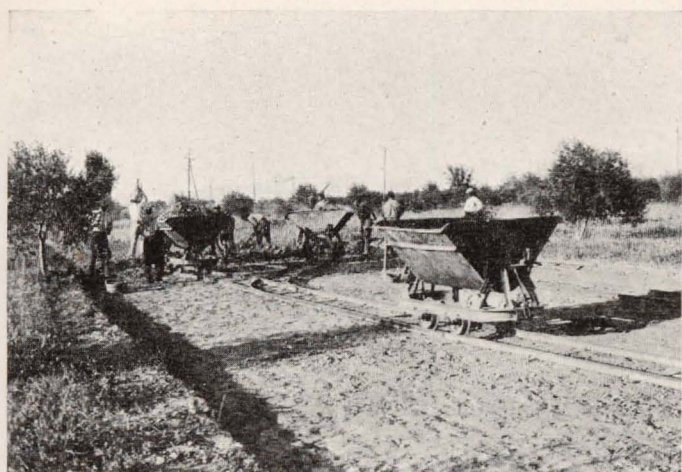
Explanación de la calle principal.
