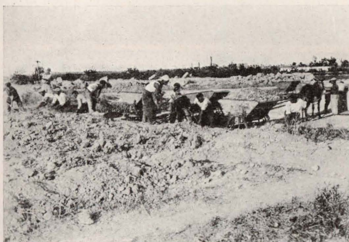
Explanación de una calle de seis metros.
