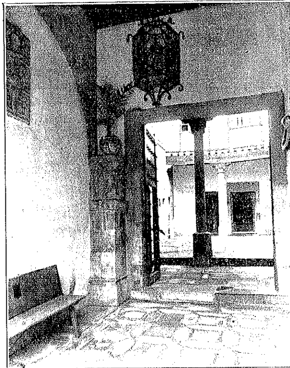
ENTRADA (PORTAL Y PATIO)
