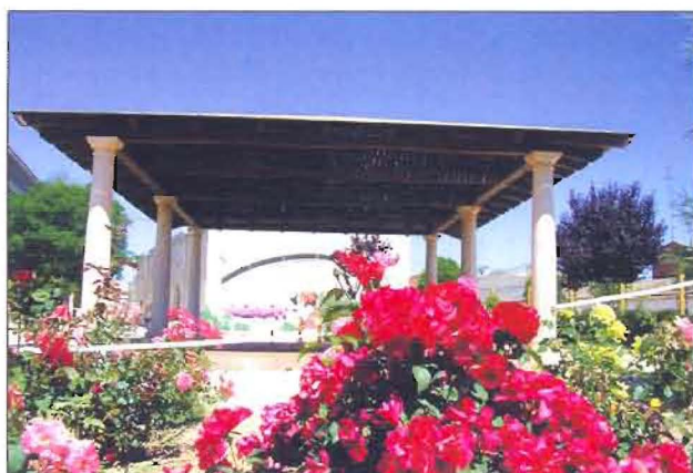
AULA AL AIRE LIBRE (EN OBRAS)
