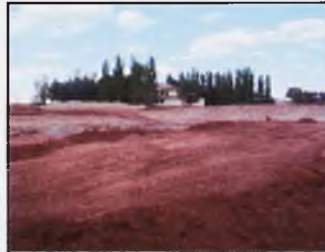
Las Obras del Velódromo (Pág. 14).
