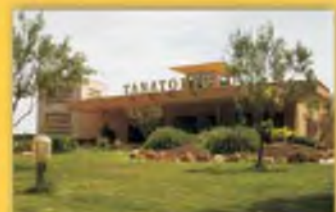
Zona Ajardinada Amplios Aparcamientos
