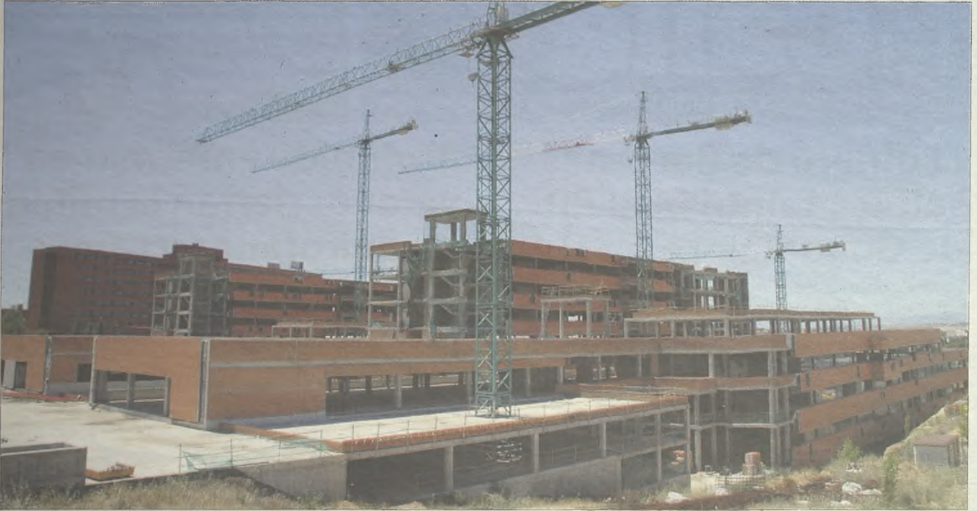
Estado actual de las obras de ampliación del hospital de Guadalajara, paralizadas desde julio de 2011.
