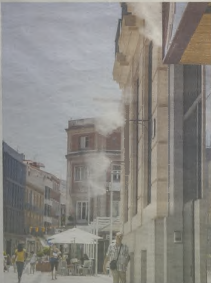
Nebulizadores instalados en la Calle Mayor./J. Roper
