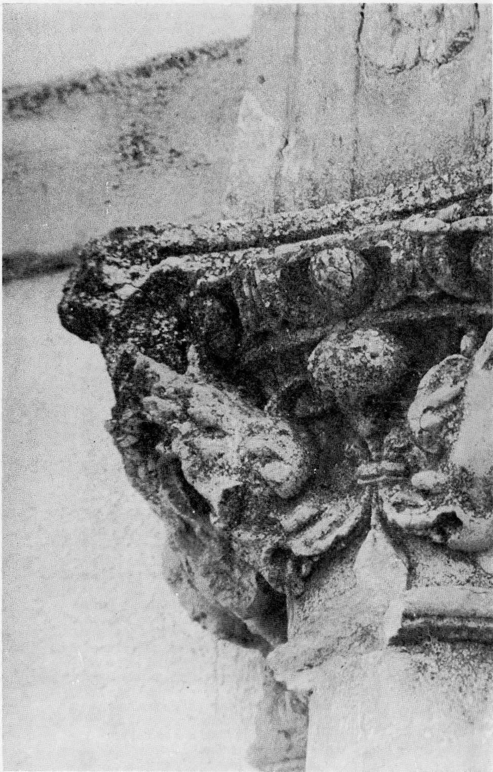
Detalle Escalera Claustro
