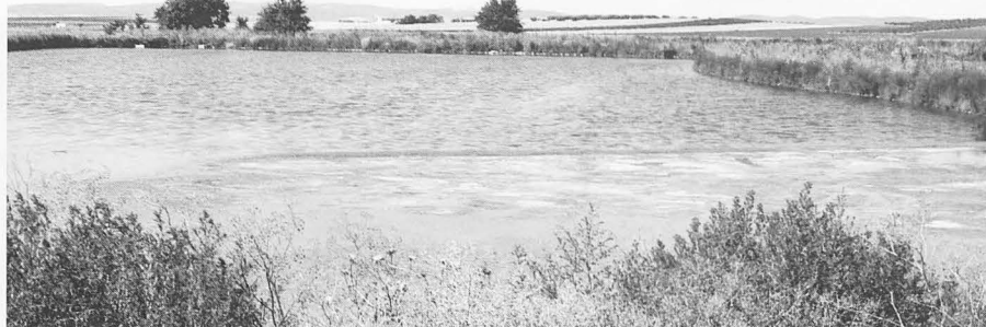
Aguas depuradas de la SAT 'La Serna'
