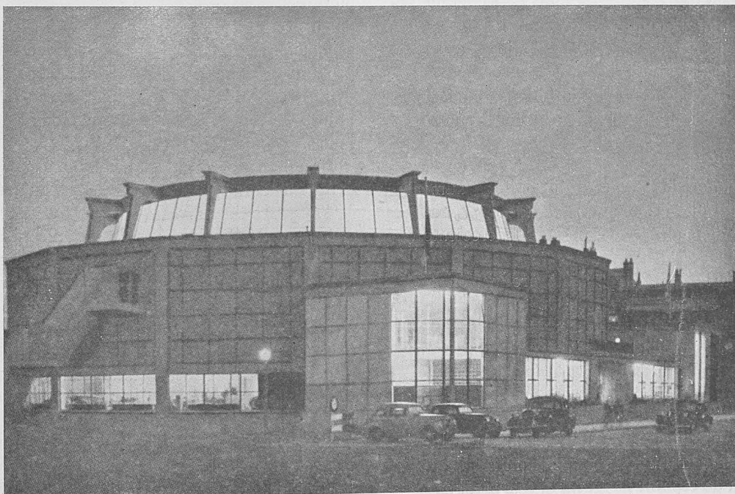
La exposición permanente de edificación y el centro de información del "BOUWCENTRUM", en Rotterdam.
