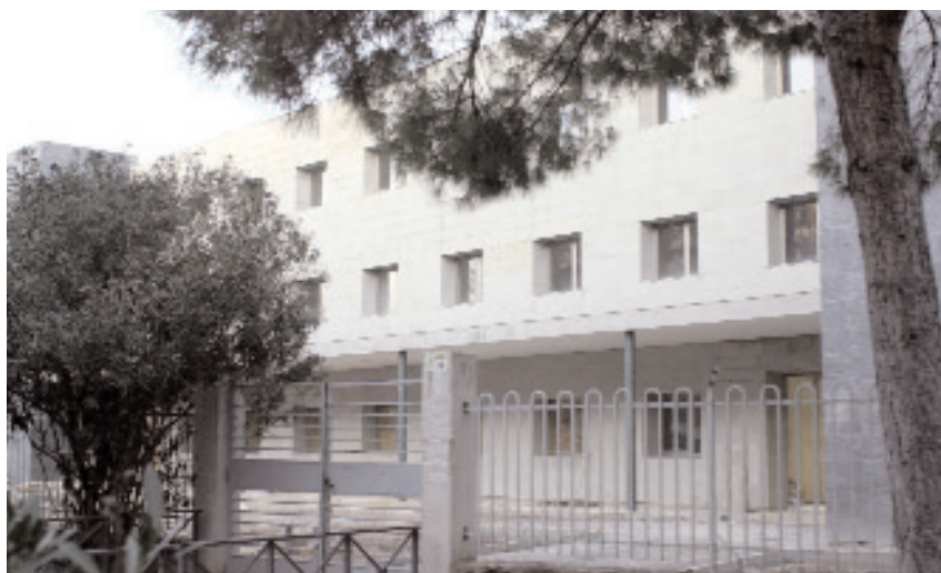
E.U.I.T.A también ha renovado sus instalaciones de cara al siglo XXI
