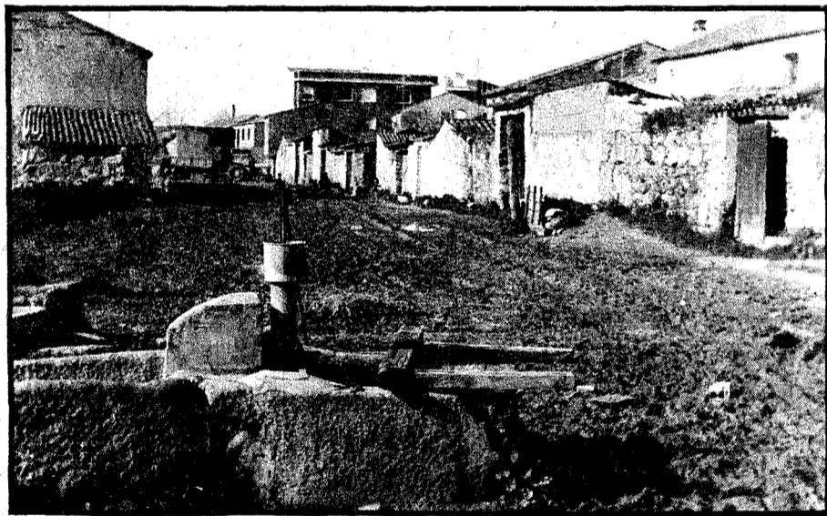
El arroyo al que vertían las aguas sucias ha sido canalizado.
