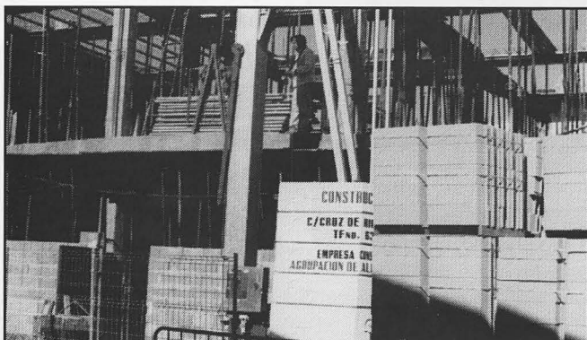
El nuevo edificio de Usos Múltiples, antigua Cámara Agraria, va a buen ritmo.
