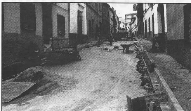
Varias calles del centro de la población están cambiando su acerado.
