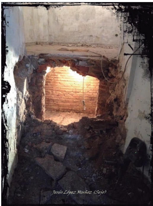
Rompimiento debajo de la escalera del Camarín del Cristo para acceso al enterramiento
