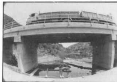
Prueba de resistencia de un puente construido por la Sección de Vías y Obras de la Diputación.
