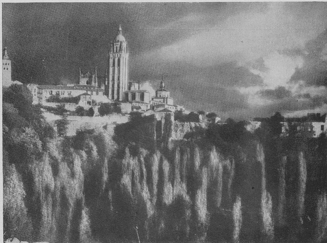
Segovia. Vista parcial.
