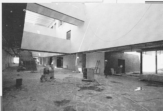
CONSTRUCCIÓN CENTRO CICLOS FORMATIVOS
